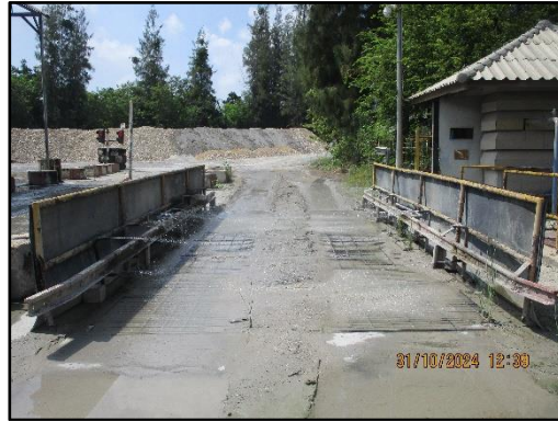
ภาพที่ 2.17 จุดล้างล้อรถบรรทุกบริเวณด้านล่าง
