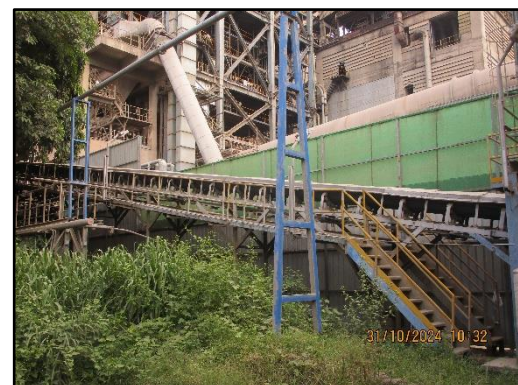
ภาพที่ 2.44 สายพานลำเลียง Biomass เข้าสู่หม้อเผาเป็นแบบปิด
