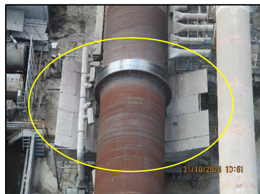
ภาพที่ 2.34 ฉากป้องกันความร้อนบริเวณ Riser pipe
